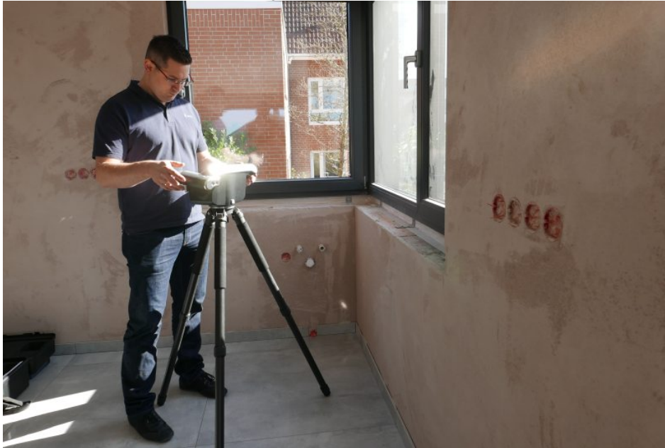
3D Aufmaß auf der Baustelle (Bild: DPS).
