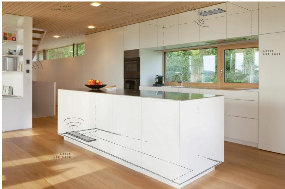
Beispiel einer vernetzten Lösung von Möbellicht und Raumbeleuchtung. Die Leitungsführung und Platzierung der Konverter und Verteilermodule liegen innerhalb des Korpus. Möbellicht und Raumbeleuchtung werden integrativ über kabellosen Wandtaster, Fernbedienung oder Smartphone gesteuert (Bild: Häfele).
