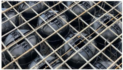
Mithilfe der von GS Kunststofftechnik produzierten Hohlkörper kann auf bis zu 40 % Beton verzichtet werden (Bild: Unidome).
