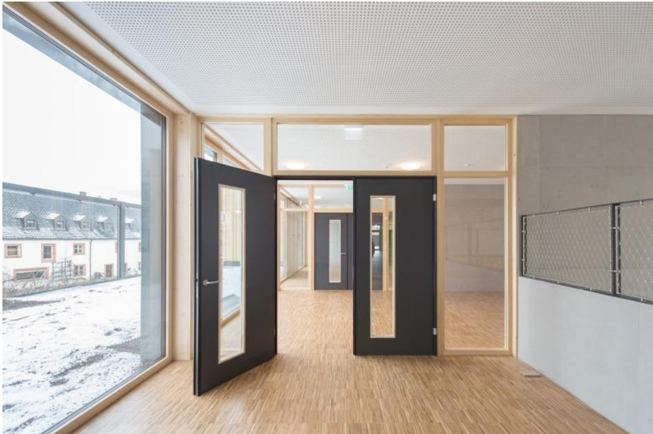
Einzelne Fingerschutztüren wurden mit Türschließern und Freilauffunktion ausgestattet, die im Falle von Rauch und Feuer automatisch dicht schließen (Bild: Küffner).
