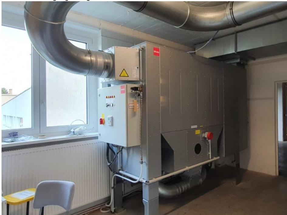
Kompaktentstauber mit einer max. Luftleistung von 10.000 m<sup>3</sup>/h (Bild: Spänex).
