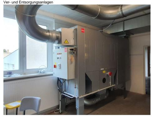
Kompaktentstauber mit einer max. Luftleistung von 10.000 m³/h (Bild: Spänex).
