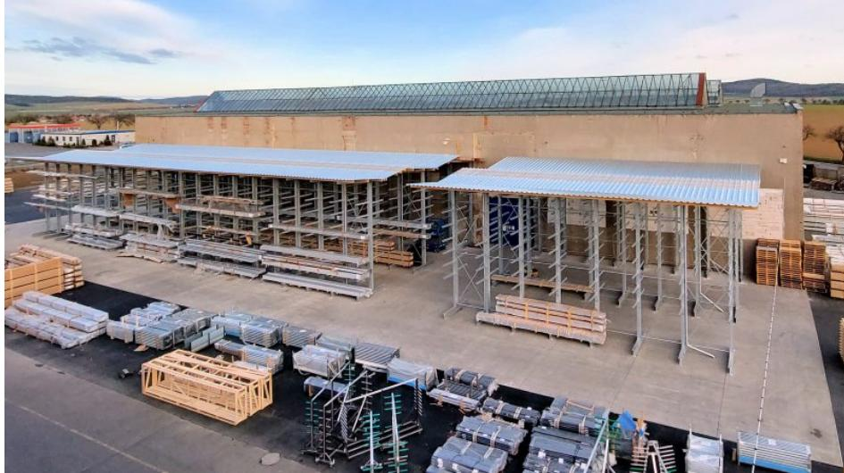
Die überdachte Kragarmregal-Anlage erhöht die Lagerkapazität und trägt zur Kostensenkung bei (Bild: Ohra).
